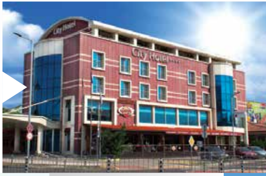
Atek Fabrika Ek Binası Hadımköy / İST.
